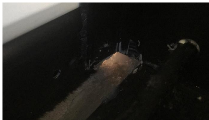
Figura A.6 – Vedação feita em silicone entre SVV e janela
