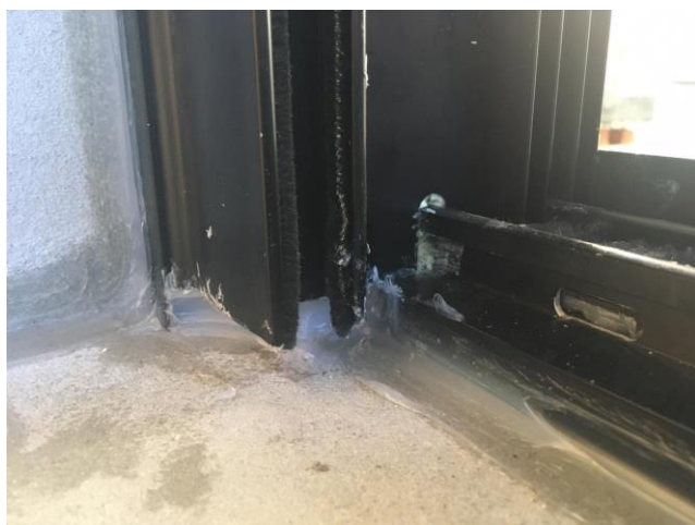
Figura A.6 – Vedação feita em silicone entre SVV e janela
