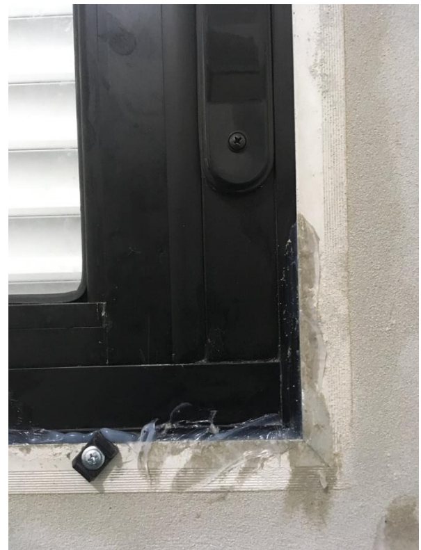
Figura A.4 – Vedação entre marco e alvenaria com silicone
