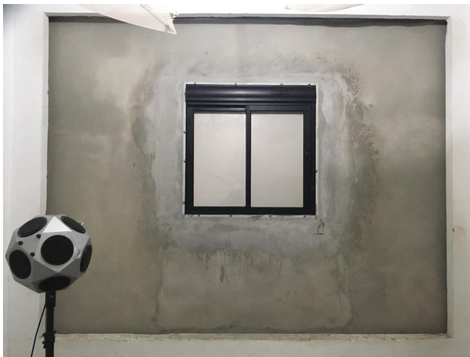
Figura A.1 – Face interna da esquadria
