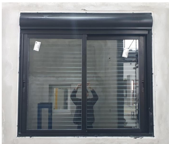
Figura 1 – Vista interna da esquadria instalada
