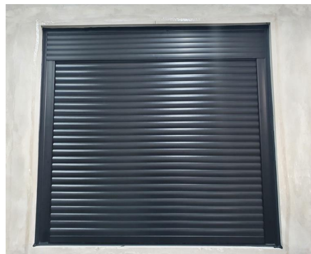
Figura 2 – Vista externa da esquadria instalada
