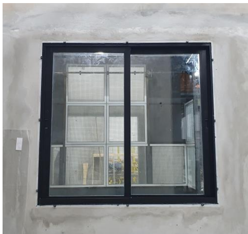
Figura 1 – Vista interna da esquadria instalada
