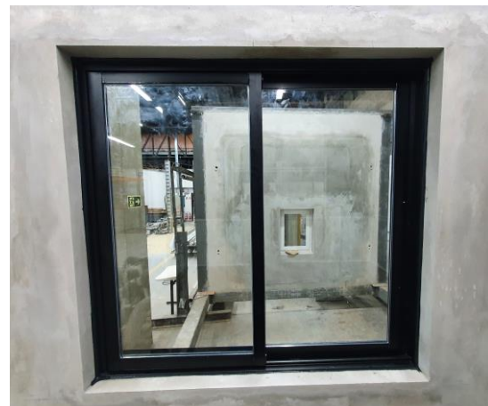
Figura 2 – Vista externa da esquadria instalada
