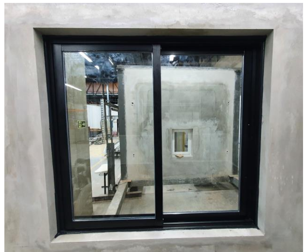
Figura 2 – Vista externa da esquadria instalada
