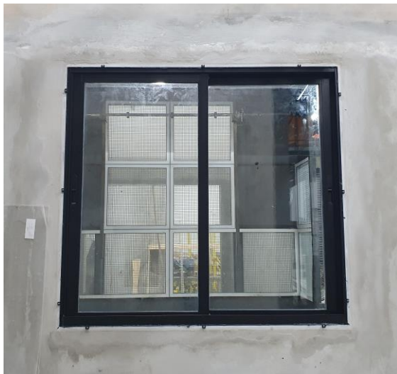
Figura 1 – Vista interna da esquadria instalada
