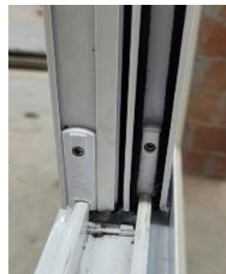
Figura C.5 – Sistema de escovas e caixa de dreno
