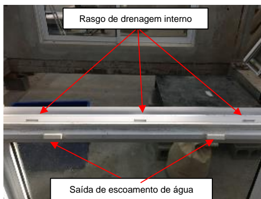
Figura C.4 – Vista do trilho da esquadria – rasgos de drenagem e saídas de escoamento de água
