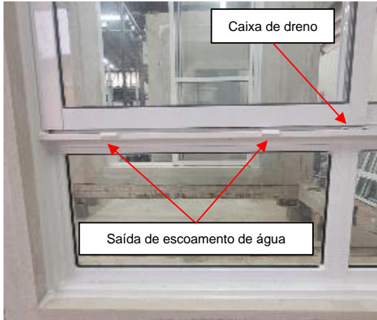
Figura C.1 – Vista externa da esquadria – saídas de escoamento de água
