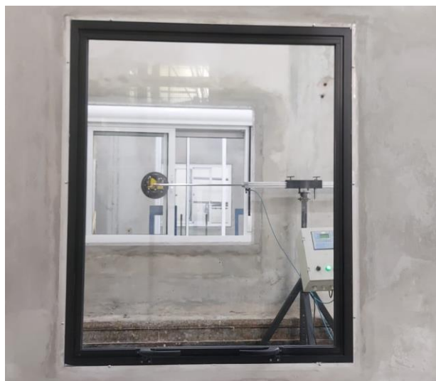
Figura 1 – Vista interna da esquadria instalada
