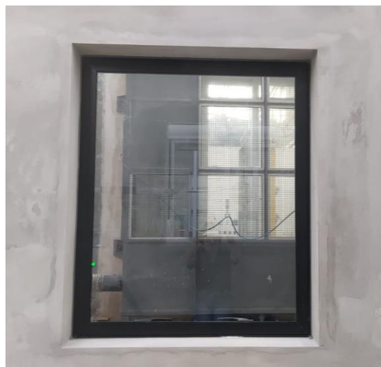
Figura 2 – Vista externa da esquadria instalada
