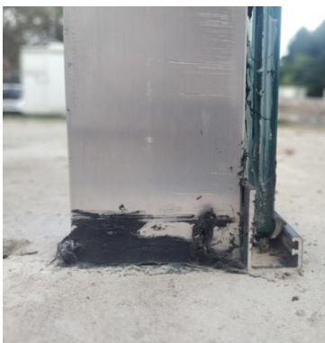
Figura B.5 – Vista da base da amostra e a fixação do elemento de fechamento
