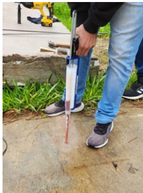
Figura B.3 – Aplicação do chumbador químico para fixação da amostra
